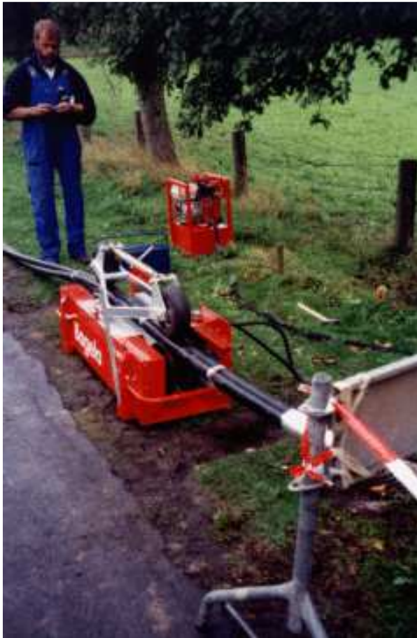
Verlegung von 3 x Einleiterkabeln 30kV
