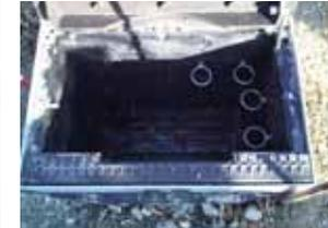
Die arretierbare Kabelaussparöffnung schützt die Kabel. Da der Schachtdeckel ohne Bedenken während der Nutzung der Anschlüsse geschlossen werden kann, wird zudem die Unfallgefahr minimiert.
