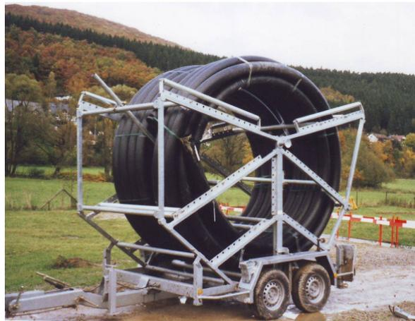
**Achtung: Das von der inneren Lage herausstehende Rohrende muss bündig mit dem Rohrbund abgeschnitten werden!**
