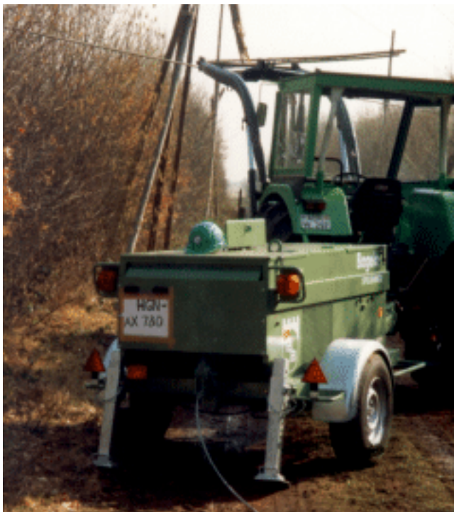
RKW 3F als Stockwinde beim Rückbau einer 110 kV-Freileitung
